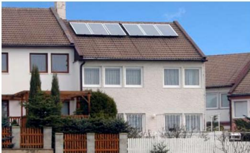
Jednou z prvních instalací podpořených komunální dotací byly kolektory na domě pana Pokuty, příznačně ve Sluneční ulici. Šestice modulů spořil majiteli více, než plánoval energetický audit. Navíc – díky viditelnosti z přilehlého hřiště – šel i inspiraci pro další obyvatele
