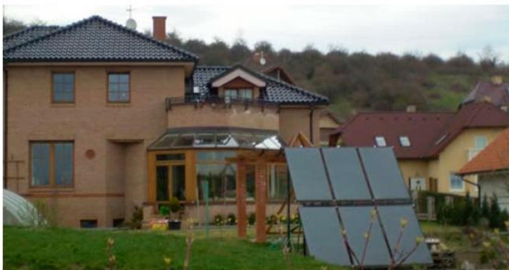
Kdo nemá vhodnou střechu, může využít i pozemek, byť většinou za cenu mírně vyšších nákladů na solární systém (například v souvislosti s délkou rozvodu)
